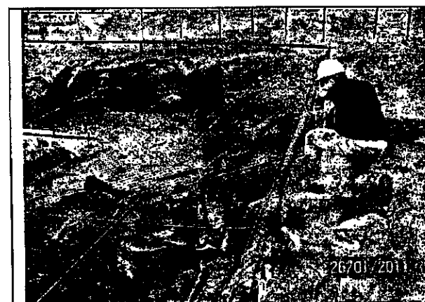
Muestreo de los lodos de la pileta
